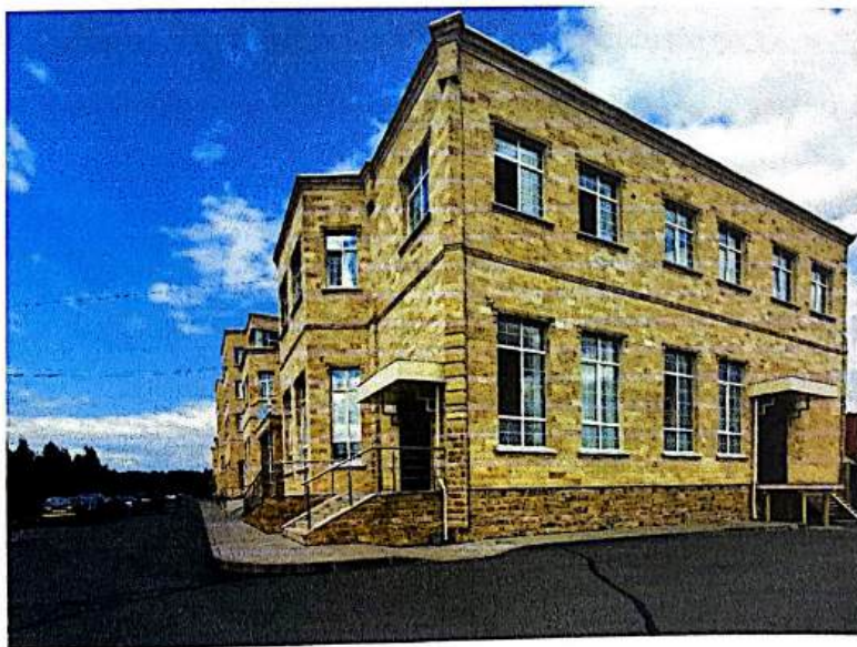
Производственный участок №2 по адресу г. Ижевск, ул. Максима Горького, 92
